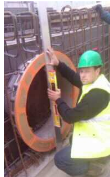
Illustration 10: Contrôle des inserts : vérification de la verticalité de l'insert par le responsable process du GREG
