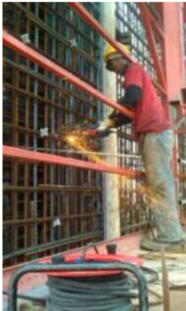
Illustration 4: Ouvrier ferrailleur en train de couper des aciers à cause d'une tige de banche
