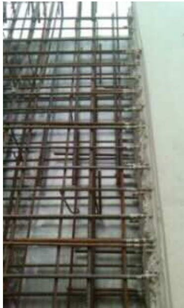
Illustration 7: Cage d'armatures avec les tiges de banches traversantes. Les aciers ligaturés peuvent être déplacés aisément.
