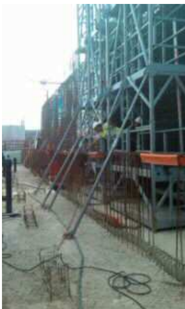
Illustration 2: ELB stabilisé par ancrage au sol
