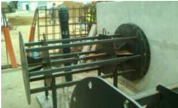
Illustration 9: Pose des inserts : gabarit d'alignement des inserts.
