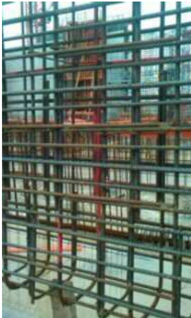
Illustration 6: cage d'armature en place. Les armatures couvertes de peintures ne sont pas soudées (suivant le plan de calepinage coffrage).
