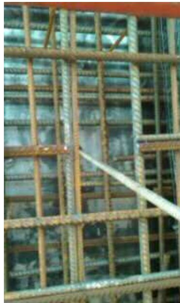
Illustration 5: aciers coupés pour le passage de la tige de banche (suite à la situation de l'image précédente)
