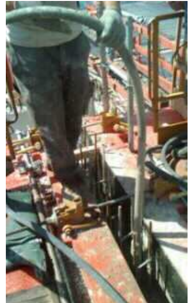
Illustration 8: Contrôle de la bonne exécution des ouvrages : coulage et vibration du béton d'un voile
